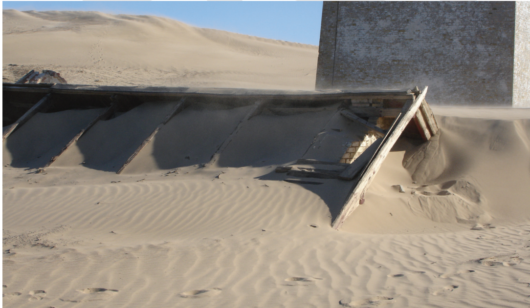
Sandet begraver bygningerne.
